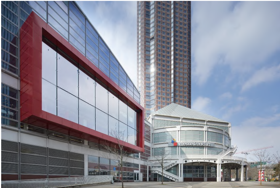
Das „Fenster zur Stadt“ an der Nordostfassade der Halle 1.
